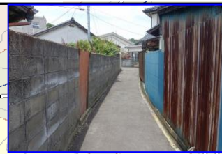
旧本山小横：ブロック傾き有
