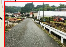
大雨時、側溝から水が溢れる
