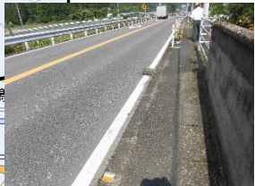
ガードレール無し
