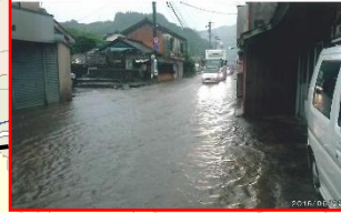
H28年6月の大雨で冠水
