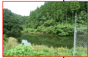
フェンス無い所あり
