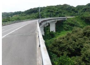
⑦ 新渚山橋 打上ダム付近にある高い橋です。身を乗り出してはいけません。
