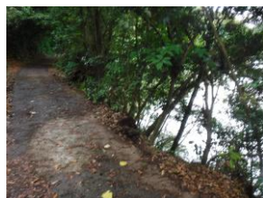
④ 丸渚だめ農道側 急に深くなっています。
