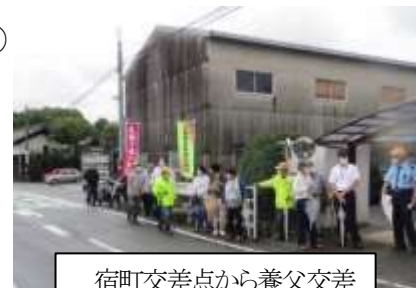
宿町交差点から養父交差点間の道路(点検箇所)
