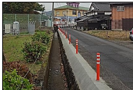
プール横～テニスコート横の用水路
