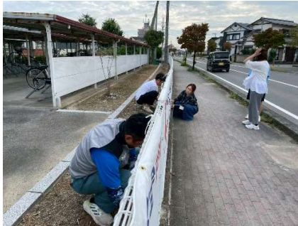
↑設置している状況です
