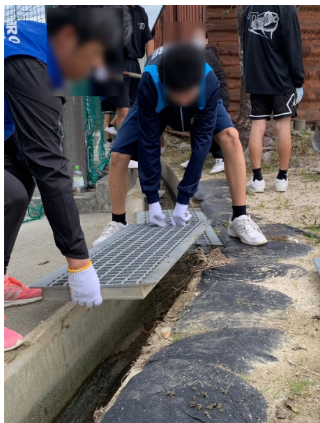
グレーチングの蓋をあけて泥を掻き出します
