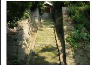
④ 階段急で幅狭い
