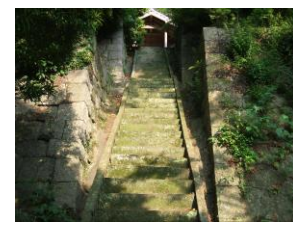
④ 階段急で幅狭い
