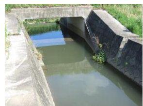
⑩ 浄水場東水路深み有
