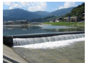
⑪ 玉島川えん堤深み有
