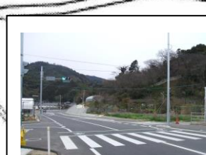
⑦ 押しボタン横断歩道 スピード車注意
