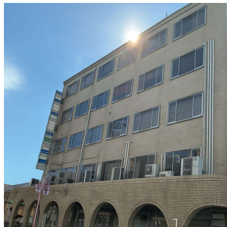
(ニュー寺元ビル外観)
