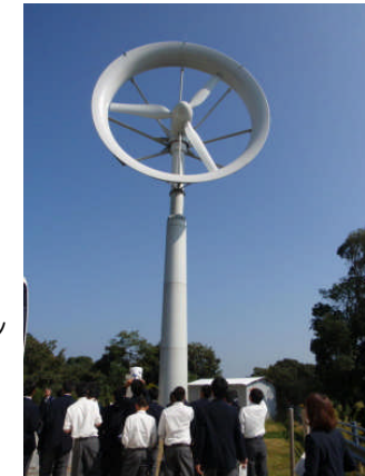
高さ33mの風レンズ風車。風向を感知して、向きを変えます。
