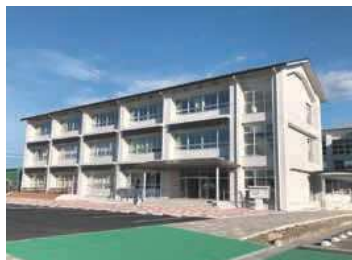
佐賀北高校通信制校舎内に設置
