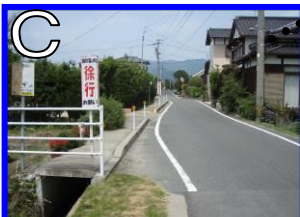
C 尾崎西 尾崎の集落の入り口で、道幅が急に狭くなっていて、車もスピードが出ているので危険である。また、東側の水路にガードレールがなく危険である。
