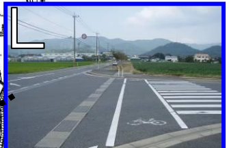
L 野寄 交差点があり信号もついているが、交通量が多い。トラックなどの大型車もよく通るので危険である。
