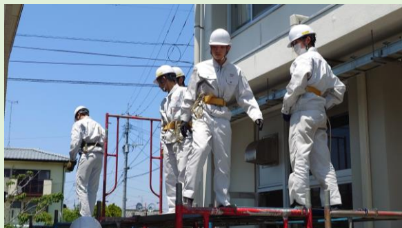
足場組立実習
