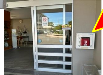
事務室前玄関外右側
