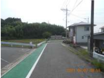
11 町道花浦線 路側帯の設置 (町)
