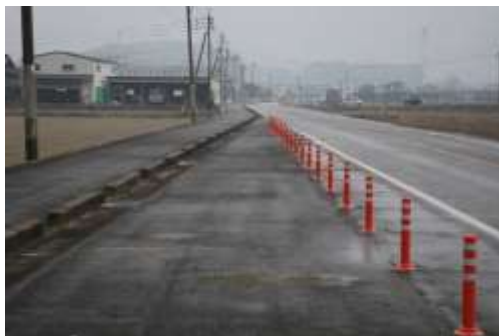
ラバーポールの設置
