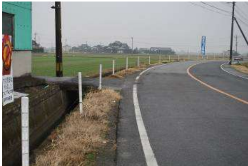
01 町道本町・馬田橋線 路肩拡幅（町）
