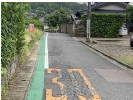
13 町道中央線 (中島区付近) 路側帯の設置 (町)
