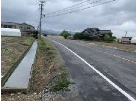
01 町道本町・馬田橋線 路肩拡幅 (町)
