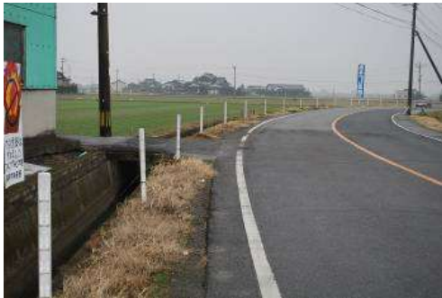
01 町道本町・馬田橋線 路肩拡幅（町）
