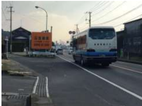
09 国道 34 号線（中島区付近） 交差点改良（町）
