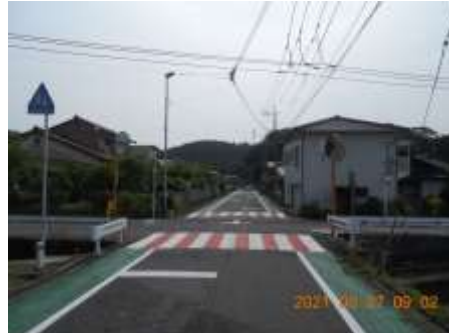
12 町道大町～江北線 交差点改良 (町)
