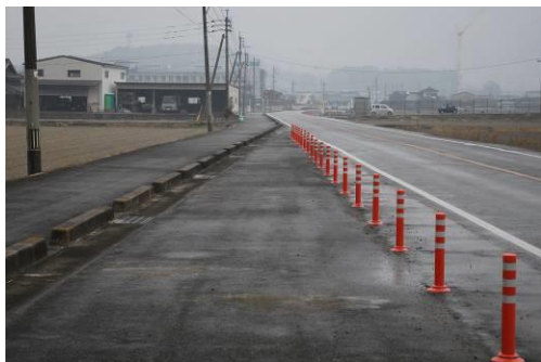
ラバーポールの設置
