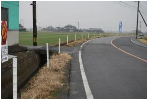
01 町道本町・馬田橋線 路肩拡幅（町）
