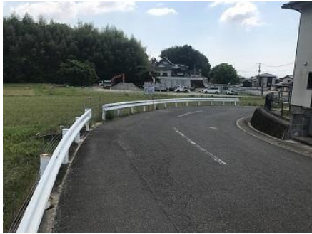
11 町道花浦線 路側帯の設置 (町)
