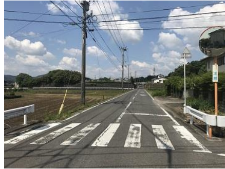
12 町道大町～江北線 交差点改良 (町)
