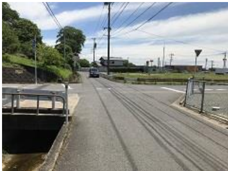
15 町道中央線（上大町、畑ヶ田付近） 道路改良、路側帯の設置（町）
