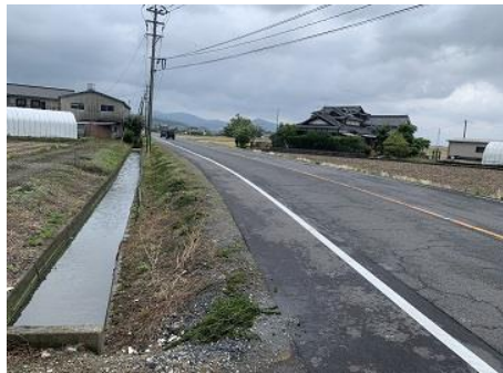
01 町道本町・馬田橋線 路肩拡幅 (町)
