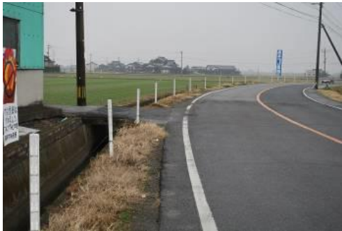
01 町道本町・馬田橋線 路肩拡幅（町）
