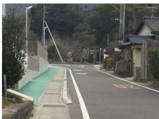
05 町道中央線 路側帯の設置 (町)
