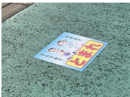
安全ステイマーク敷設
