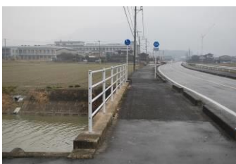
08 県道白石大町線 転落防止柵の設置 (県土木事務所)
