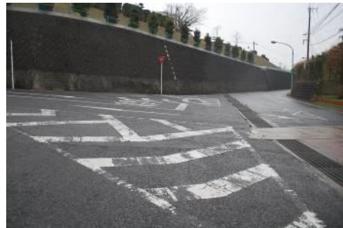
06 町道中央線（公民館南） 交差点改良（町）
