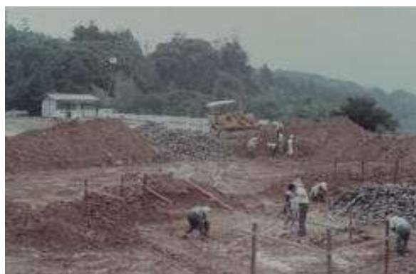
基礎工事の様子です
