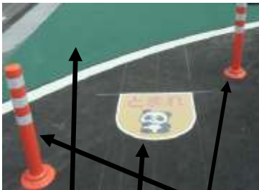
カラー舗装 ポール 止まれシール
