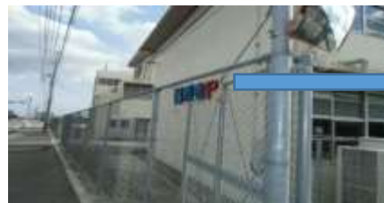
校舎北側駐車場(保護者駐車場)
