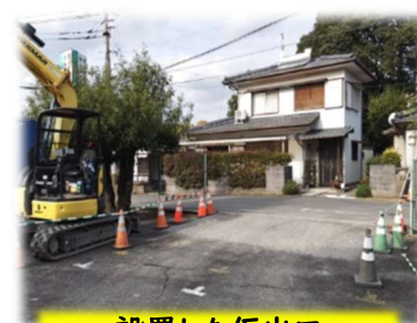
設置した仮出口
