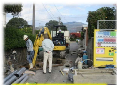
下水道工事の様子
