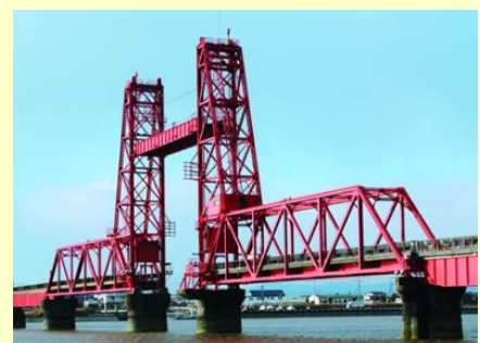
【国指定重要文化財 筑後川 昇開橋】
