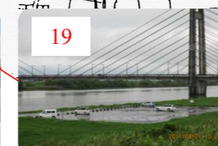
19 天建寺橋下駐車場(浜田・坂口両側)に他県ナンバーなどの車が常時駐車している。ゴミも落としている。
