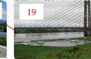
19 天建寺橋下駐車場(浜田・坂口両側)に他県ナンバーなどの車が常時駐車している。ゴミも落としている。
