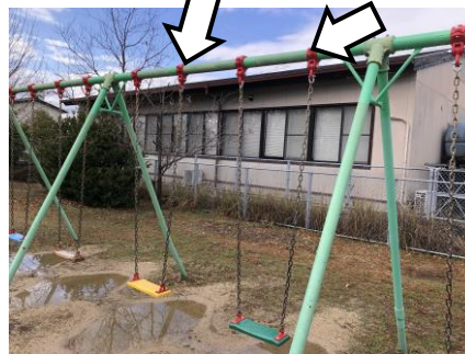
支柱・梁の接合部分の金属を交換しました。
