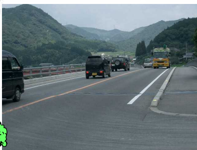
☆4 【新橋】 直線道路で交通量多い。歩道に縁石がなく、あぶない！
