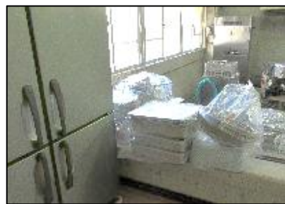
給食室内の設備入替
