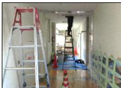
家庭科室の空調工事
