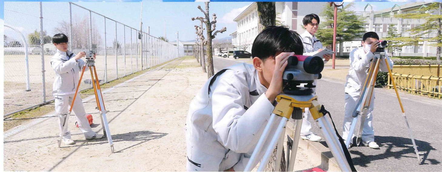
〈測量実習〉グループでの活動を通して土木の基礎と、友情が深まります。
