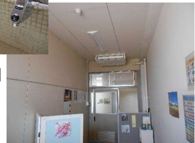
[新設エアコンと照明]
