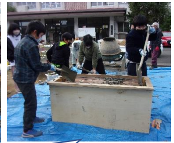
コンクリートを型に流し込みました。バイブレーターという道具も使いました。
