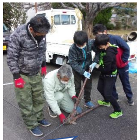
骨組となる鉄の棒を曲げました。丁度理科で習っている「てこ」の知識が役に立ちました。
