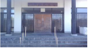
川副武道館（避難所）
