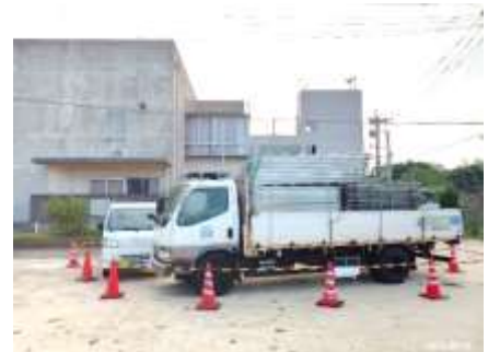
【足場の搬送の様子】
