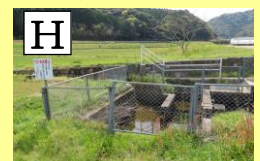
竹下川(伊岐佐川支流)の取水口
