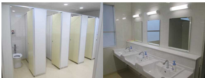
個室トイレ(洋式)
